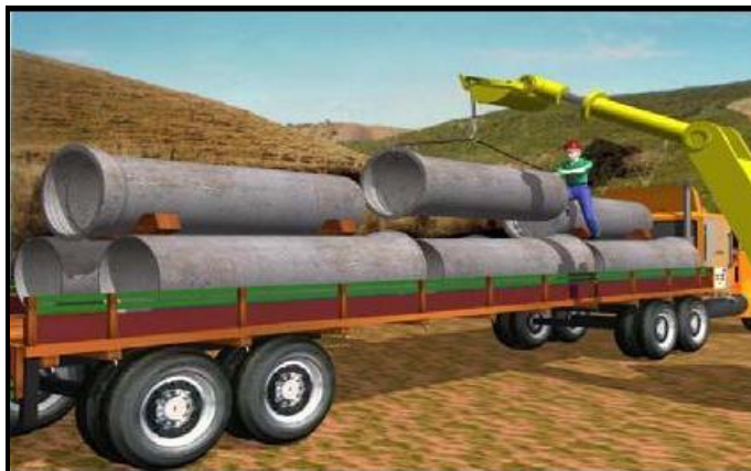
Figura 11 – Descarregamento dos tubos
