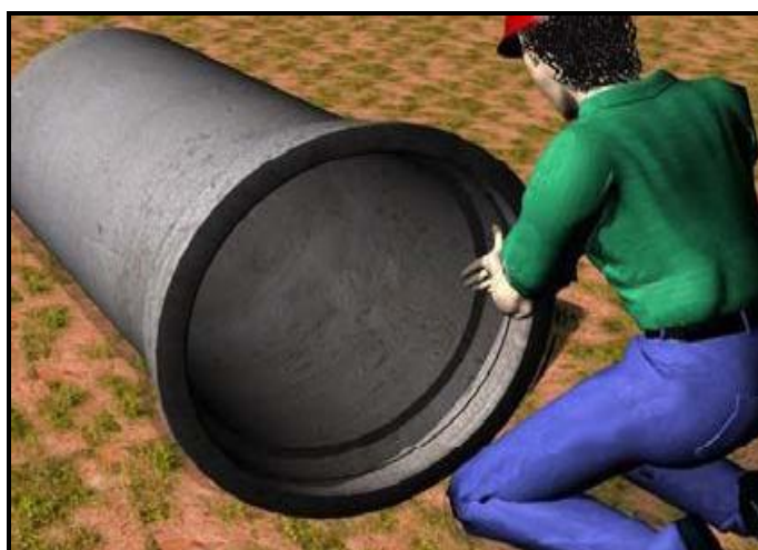
Figura 14 – Lubrificação do anel de borracha
