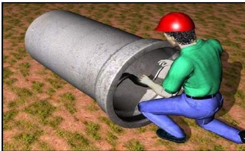
Figura 13 – Colocação do anel de borracha
